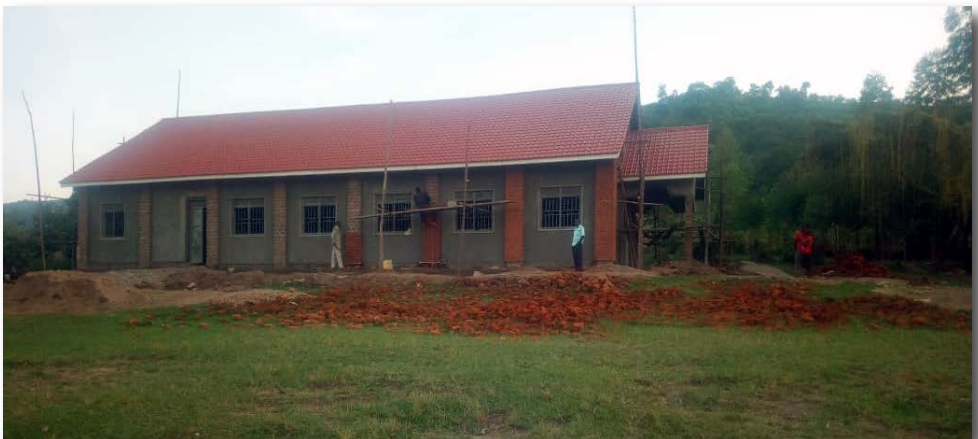
Ein weiterer wichtiger Punkt sind die Renovierungen und Instandhaltungen an unseren Gebäuden.
